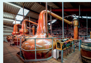
Instalație de distilare a băuturilor alcoolice
