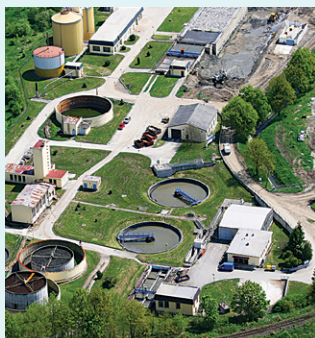
Stație de epurare a apei
